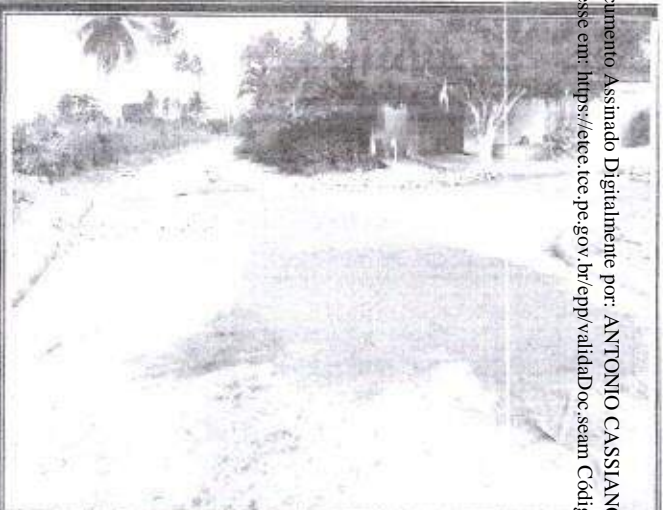
FOTO 12 – Rua em Frente a escola – Loteamento Diogo
