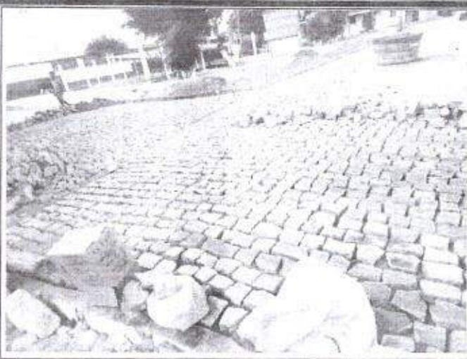
FOTO 11 – Rua em Frente a escola – Loteamento Diogo
