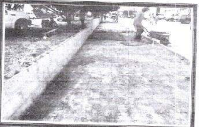
Foto 18 - Vistas dos serviços de concretagem das calçadas.
