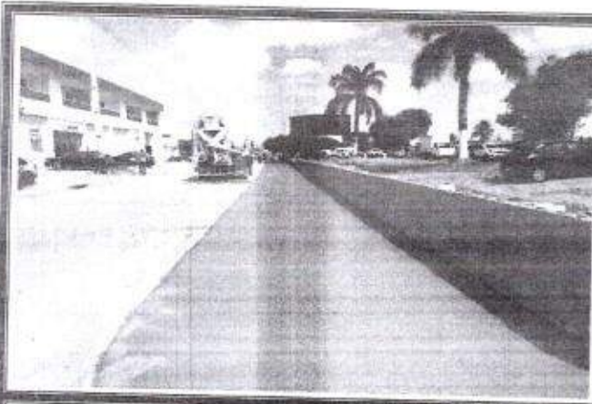
Foto 15 - Vistas dos serviços de concretagem das calçadas.
