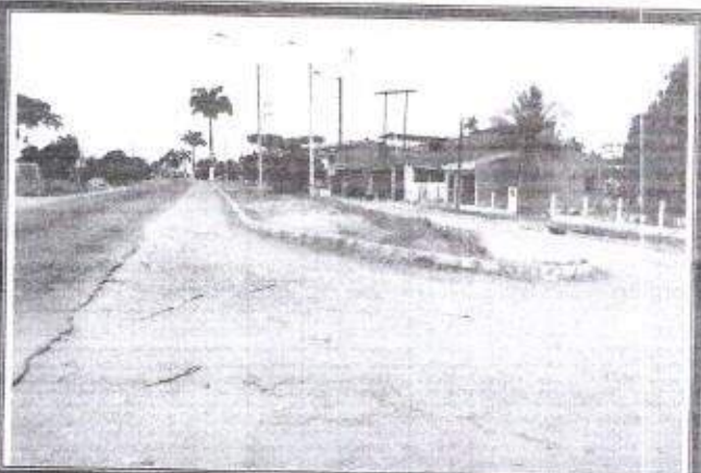
Foto 12 - Vistas dos serviços assentamentos dos meio-fio.
