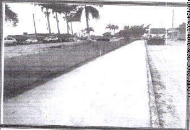
Foto 16 - Vistas dos serviços de concretagem das calçadas.
