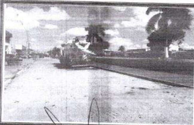
Foto 17 - Vistas dos serviços de concretagem das calçadas.
