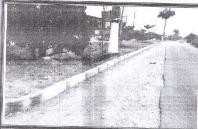
Foto 13 - Vistas dos serviços assentamentos dos meio-fio.
