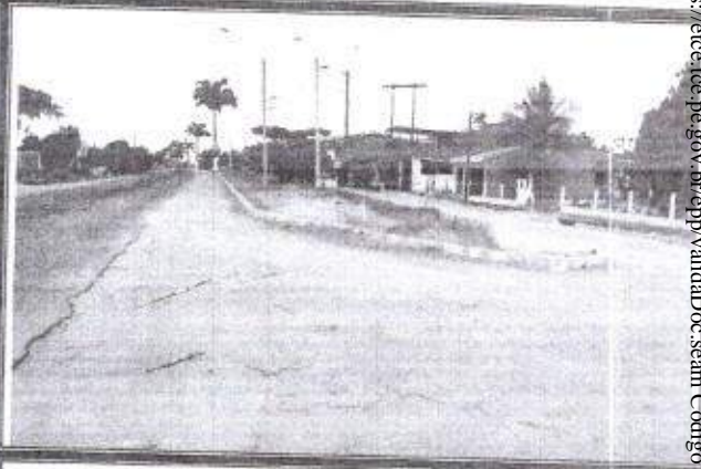
Foto 14 - Vistas dos serviços assentamentos dos meio-fio.
