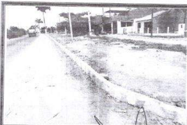
Foto 11 - Vistas dos serviços assentamentos dos meio-fio.
